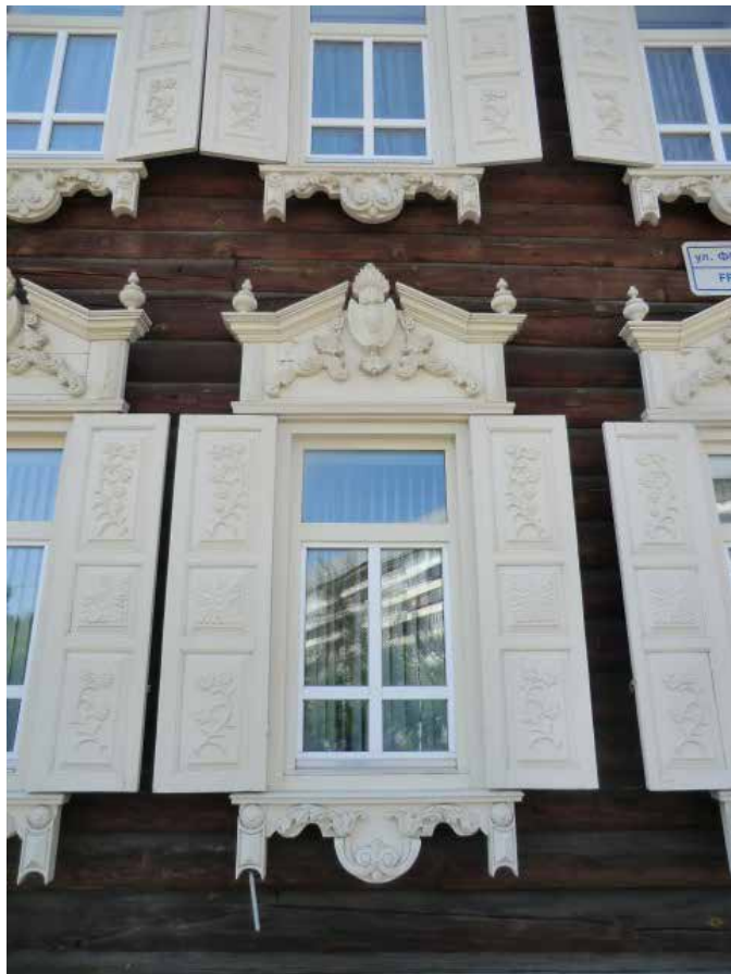
Рис. 2. Декоративный барочный наличник дома в исторической части г. Иркутска. Фото О. Севан, 2013 г.
