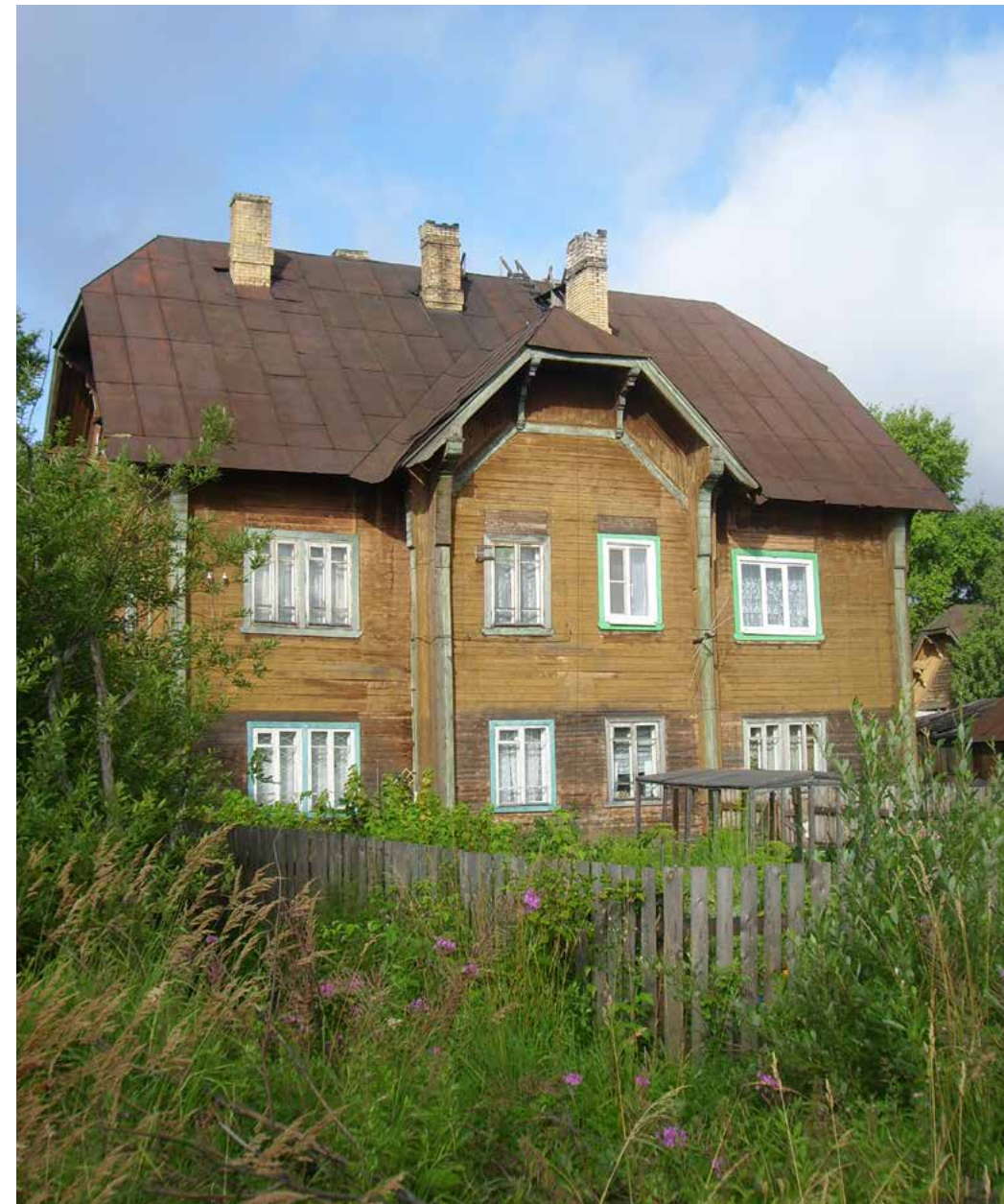
Рис. 5. г. Няндомы, Архангельская область. Двухэтажный жилой дом (Дом начальника дистанции пути). Улица Урицкого, д. 8. Фото Н. Бессараба, 2011 г.
