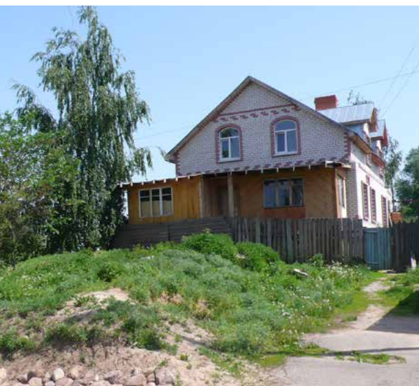
Рис. 3. Современная застройка на городецком валу. Пример нарушения законодательства о культурном наследии. Фото авторов, 2007 г.
