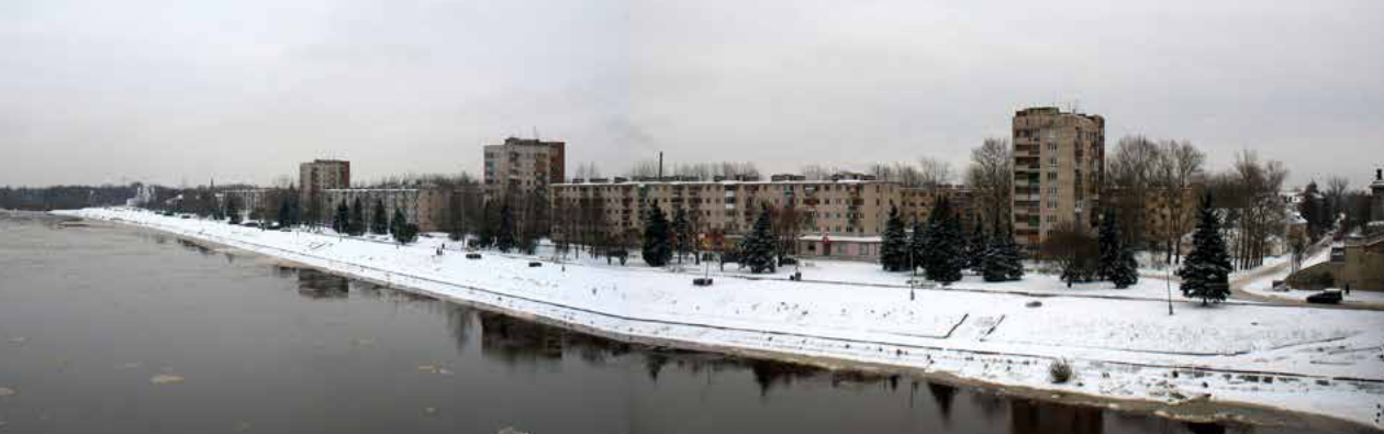
Рис. 4. Застройка конца 1960-х гг. набережной Торговой стороны. Фото В. Попова, 2006 г.
